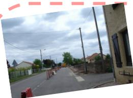
**Travaux de sécurisation sur la RD 70 :** La sécurité des piétons de la rue de Lunéville est garantie grâce à un trottoir sur la partie droite de la route. Sur l'existant du côté gauche, nous avons fait poser de l'enrobé.
